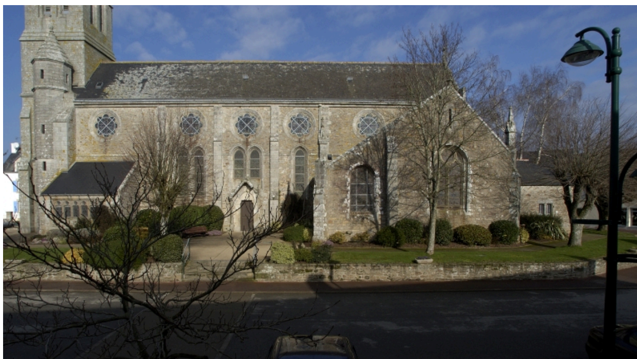
Rédené, église paroissiale Notre-Dame-de-Lorette : élévation sud, état en 2005
