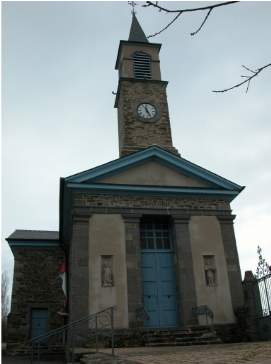
Elévation Ouest : vue générale
