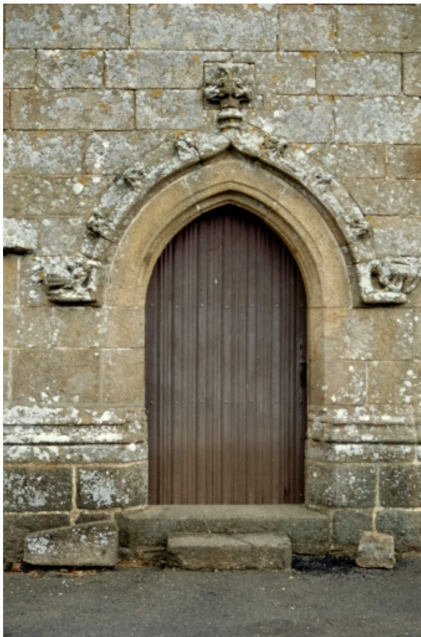
Elévation sud : détail porte.
