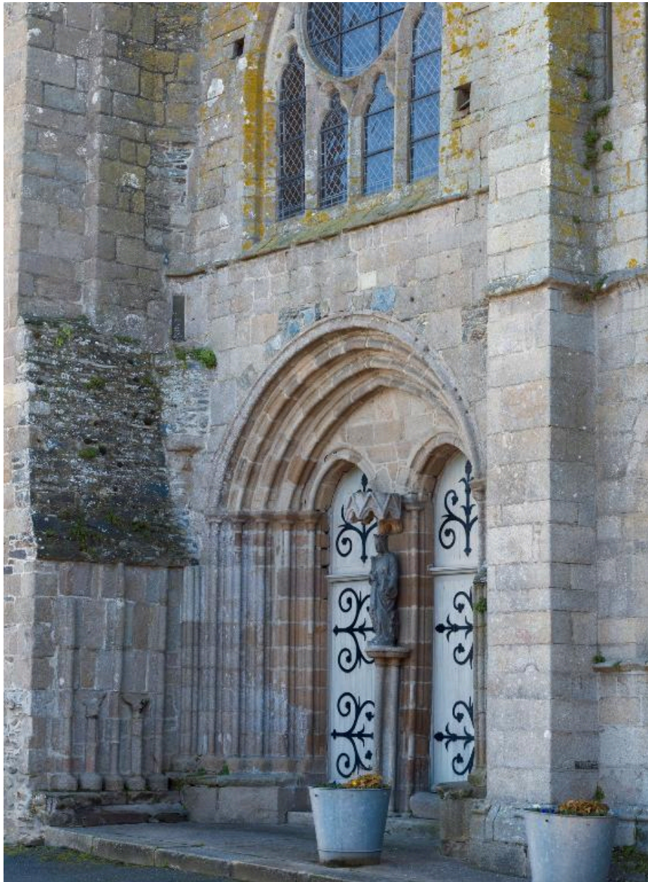
Façade ouest. Le portail
