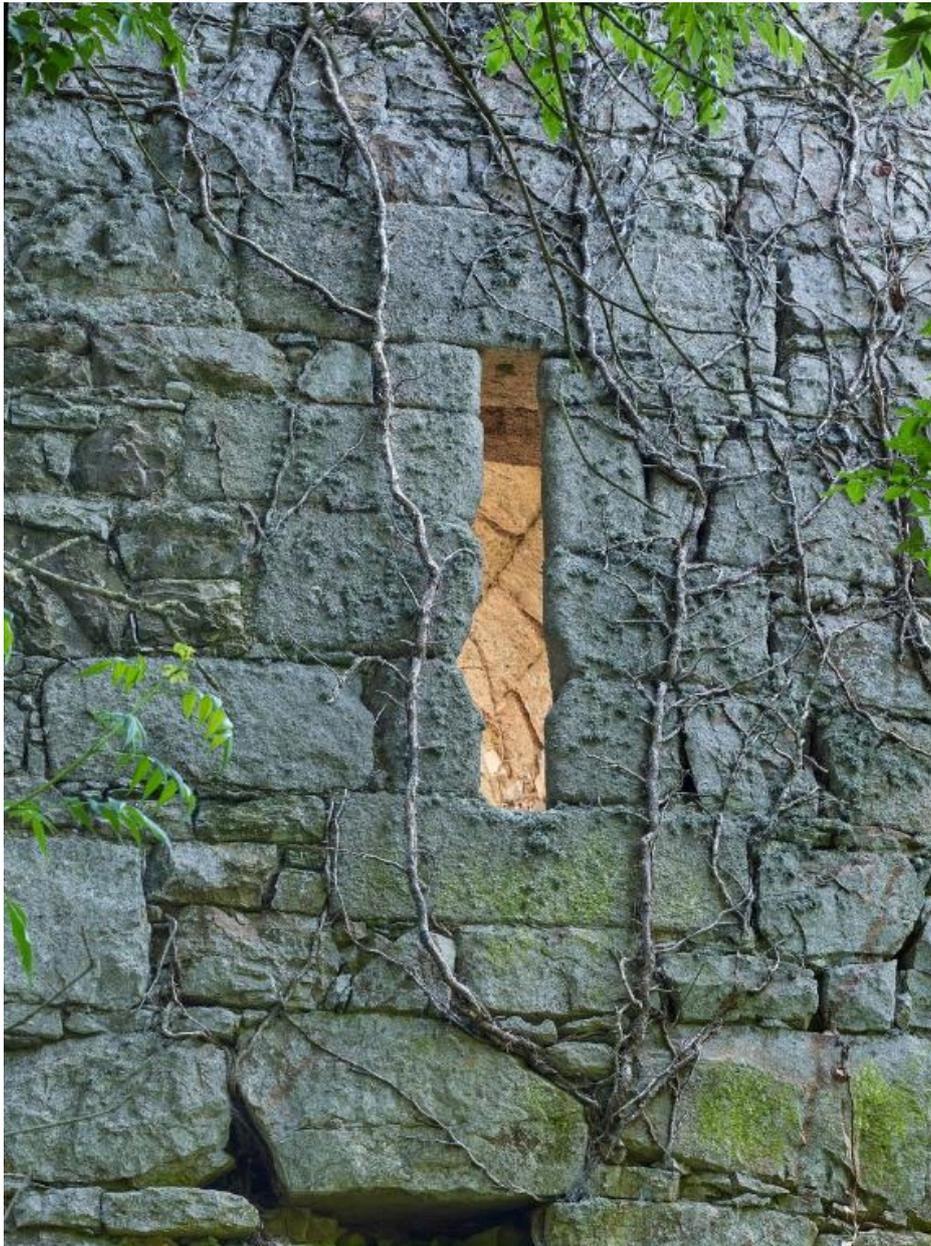
Vue du rez-de-chaussée surélevé : arbalétrière-canonnière (fente pour le tir à l'arbalète ou à l'arc et un orifice rond pour le tir avec des pièces d'artillerie) orientée vers le Nord-est
