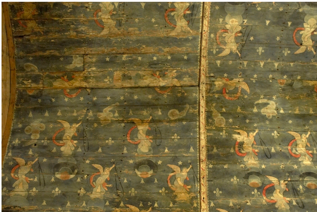
Voûte lambrissée de la chapelle du bras sud, autre vue
