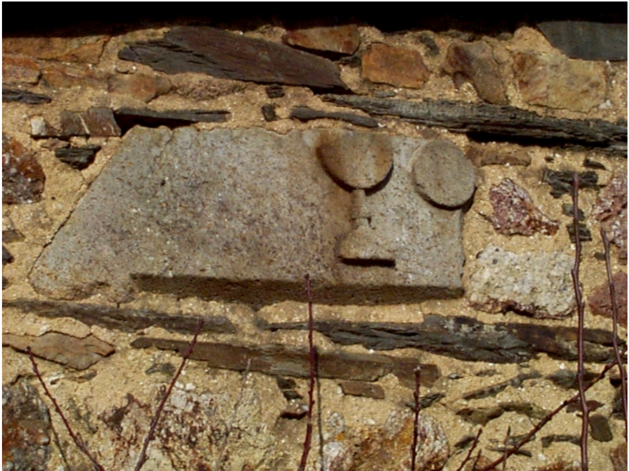
Pierre de remploi portant calice et patène en relief insérée dans le mur du croisillon sud : détail
