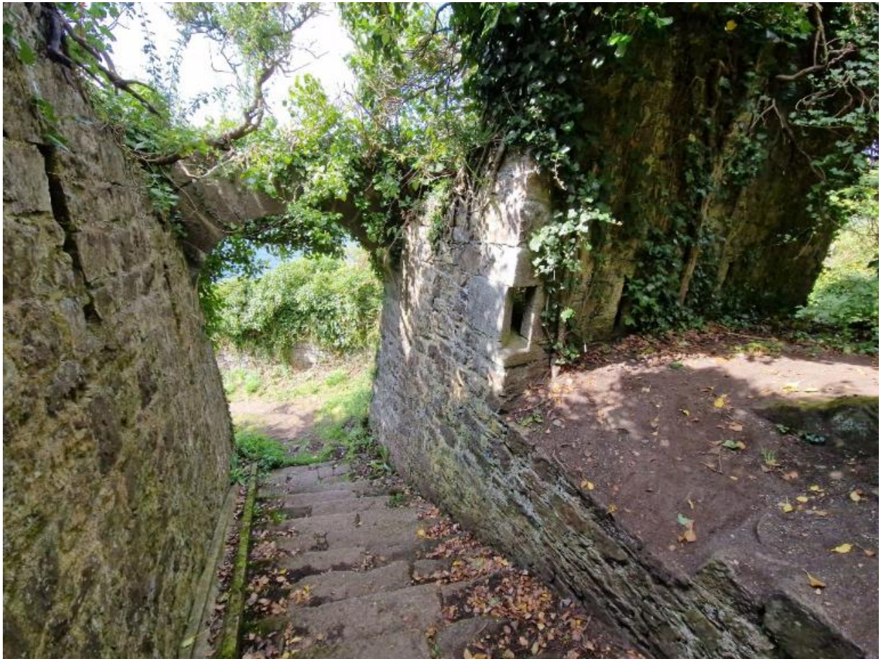
Vue de l'escalier menant à la batterie basse avec sa porte défendue de créneaux de tir (état en 2024)
