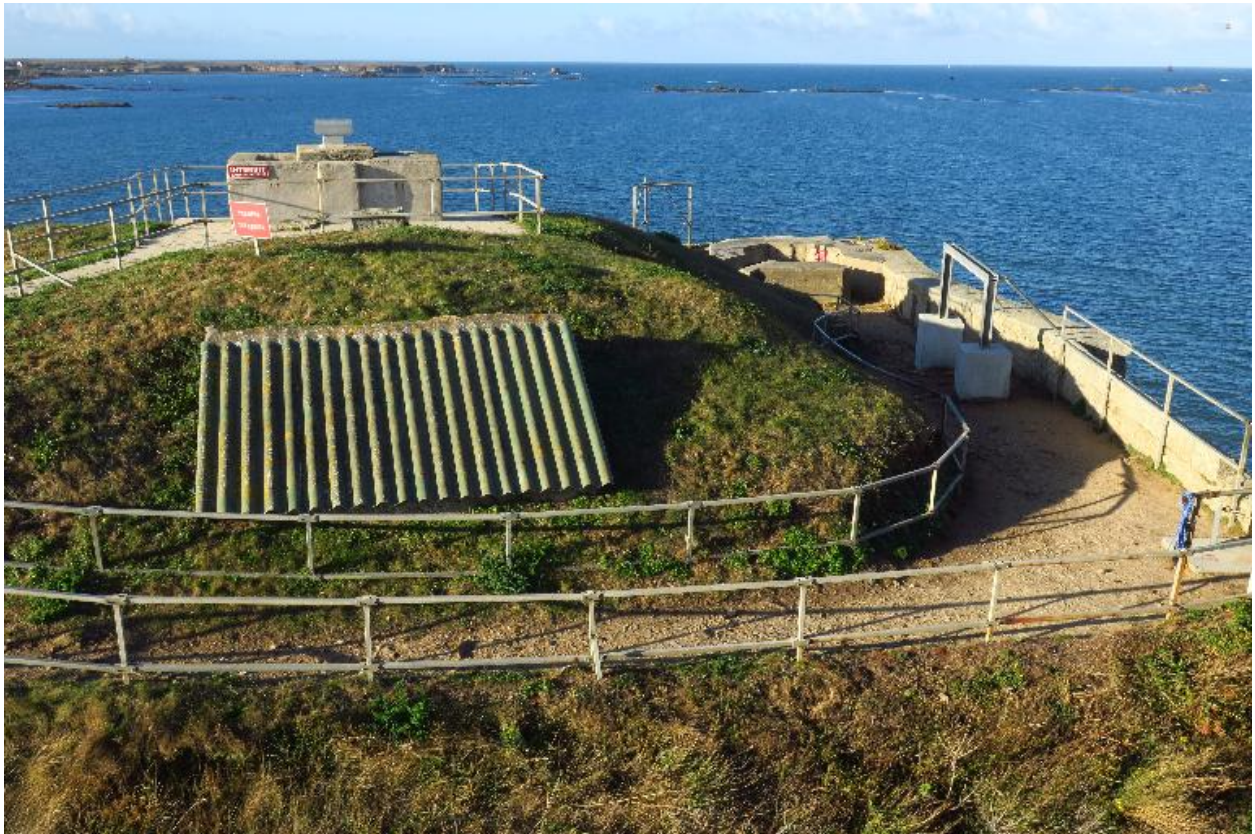
Saint-Pierre-Quiberon, fort de Penthievre, dessus du magasin à poudre de 1885 et ouvrage allemand.
