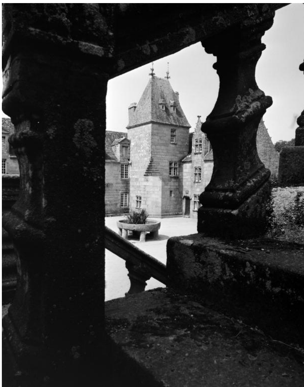
Logis, tour d'angle et balustrades de l'escalier
