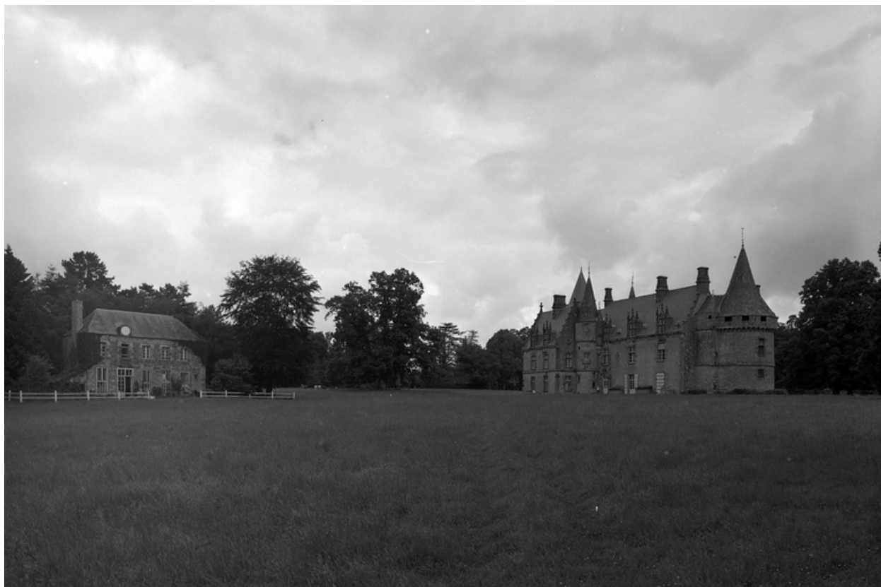
Vue de situation sud-ouest.
