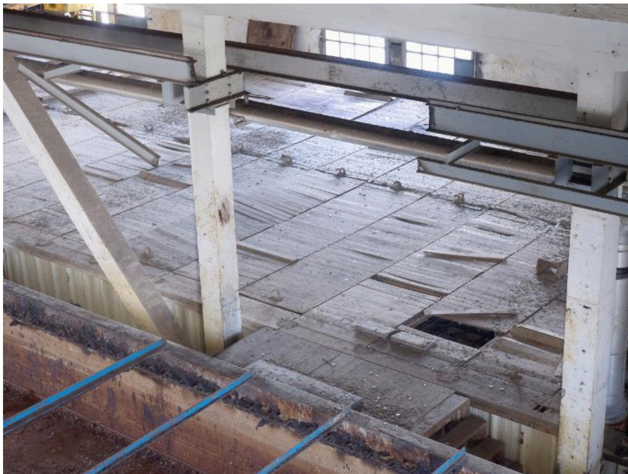
Frigorifique de Lorient : 4e étage, plancher couvrant et isolant un ensemble de bacs de congélation
