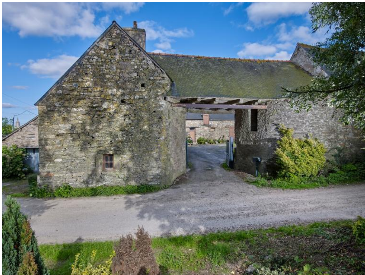
Portail d'entrée. Vue générale ouest
