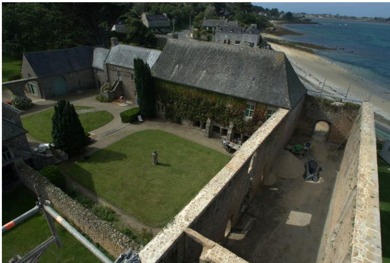
Vue de situation de l'ancien couvent prise depuis la hauteur du clocher de la chapelle
