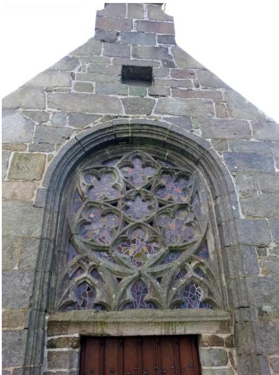
Chapelle Saint-Laurent dite de Tromenec : baie
