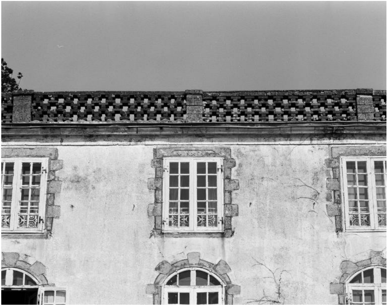
Logis, élévation sud, fenêtre médiane du 2ème étage.
