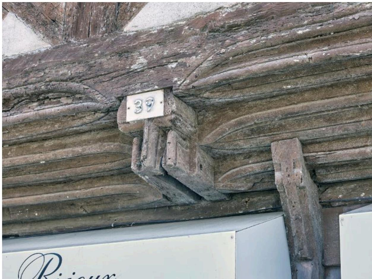
Le poteau central a été décalé vers la droite : on constate la mortaise orpheline sous l'about de solive mouluré.
