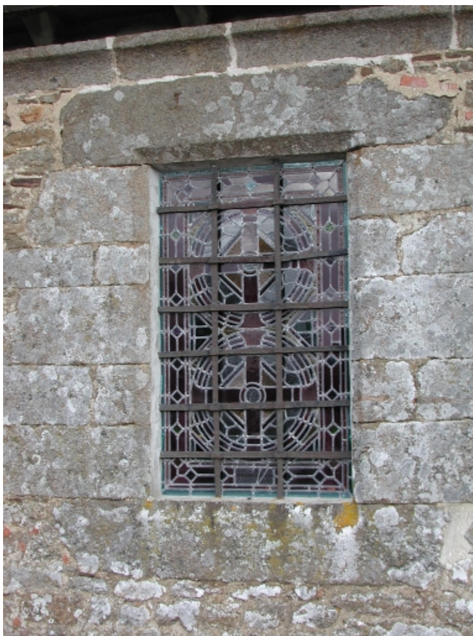
Mur sud de la nef, détail d'une fenêtre
