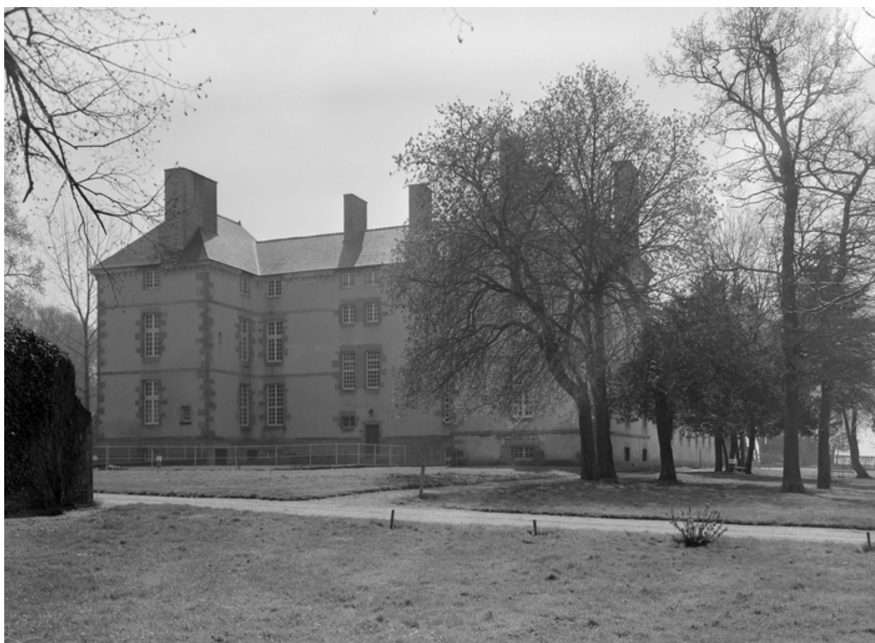
Vue générale façade nord
