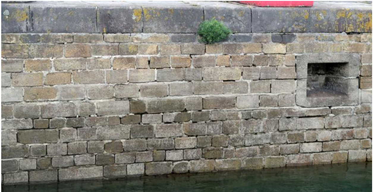
3e bassin, quai Nord, maçonnerie et organeau
