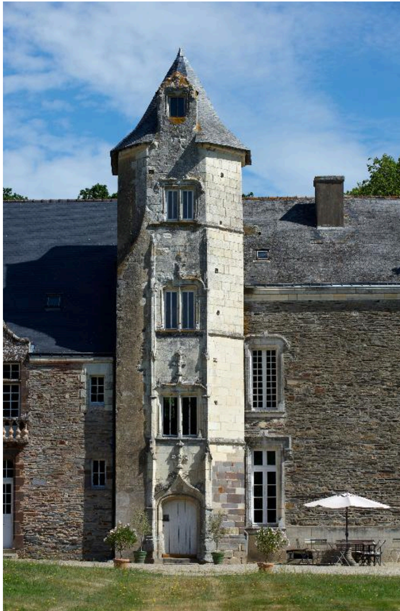
Vue rapprochée de la tour d'escalier
