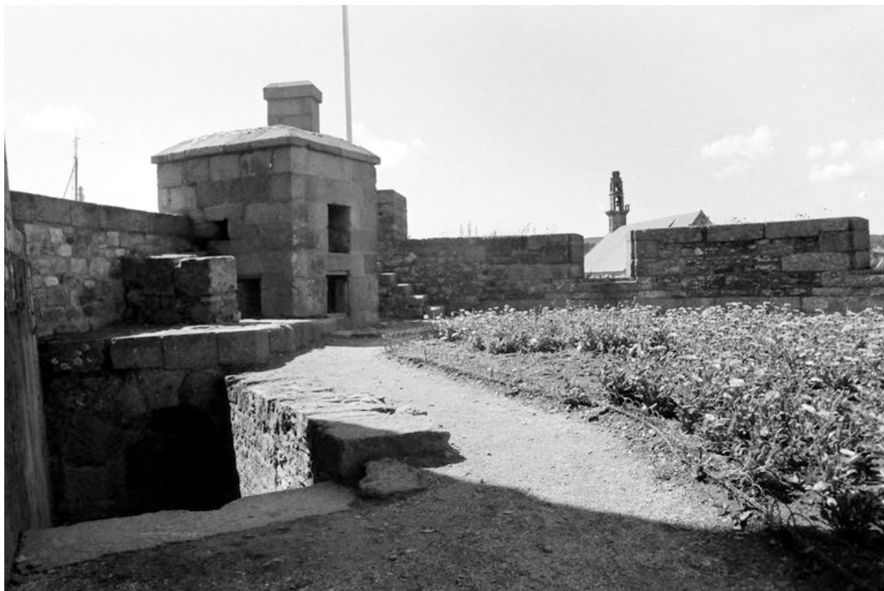
Vue de la tour Vauban en 1967 : four à boulet et galerie de fusillade
