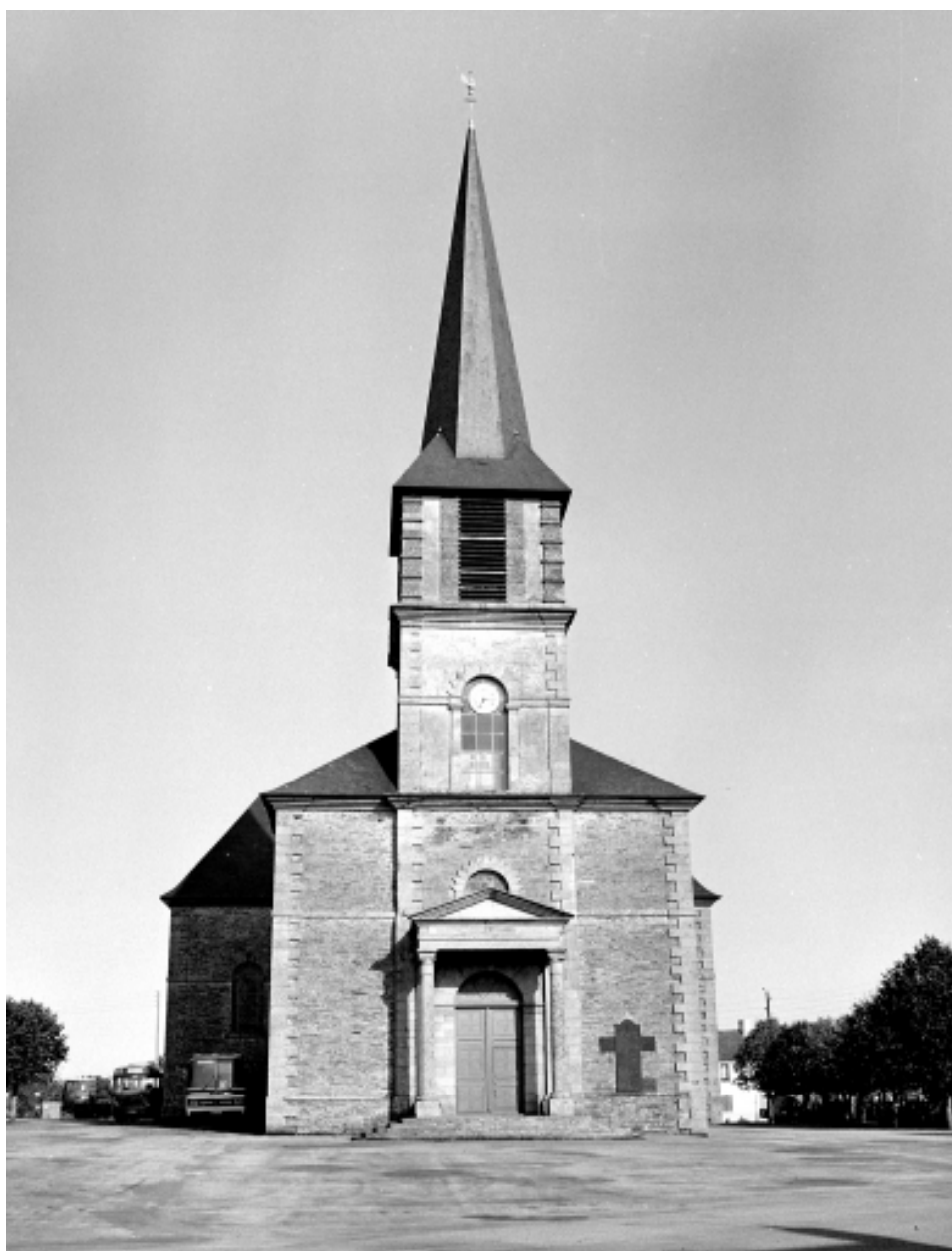
Elévation ouest : vue générale
