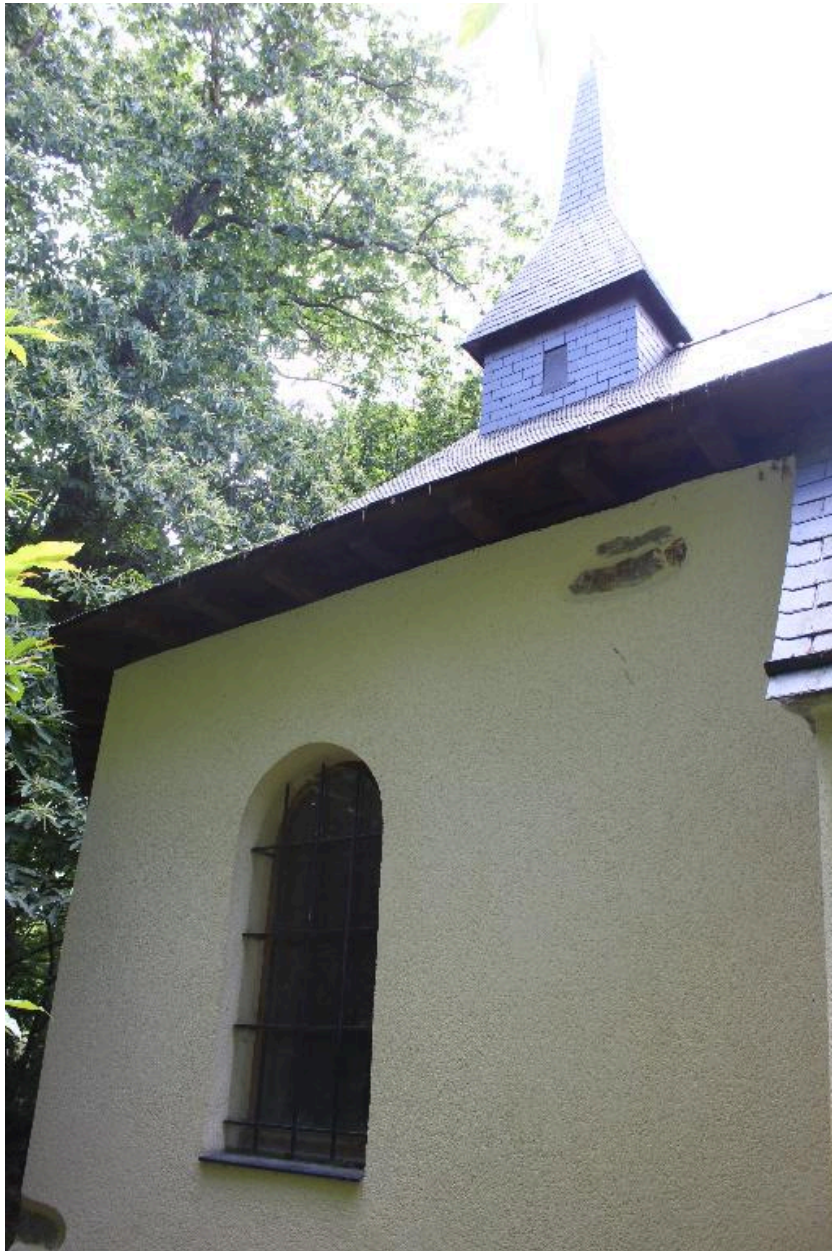
Baie façade nord - Vue générale
