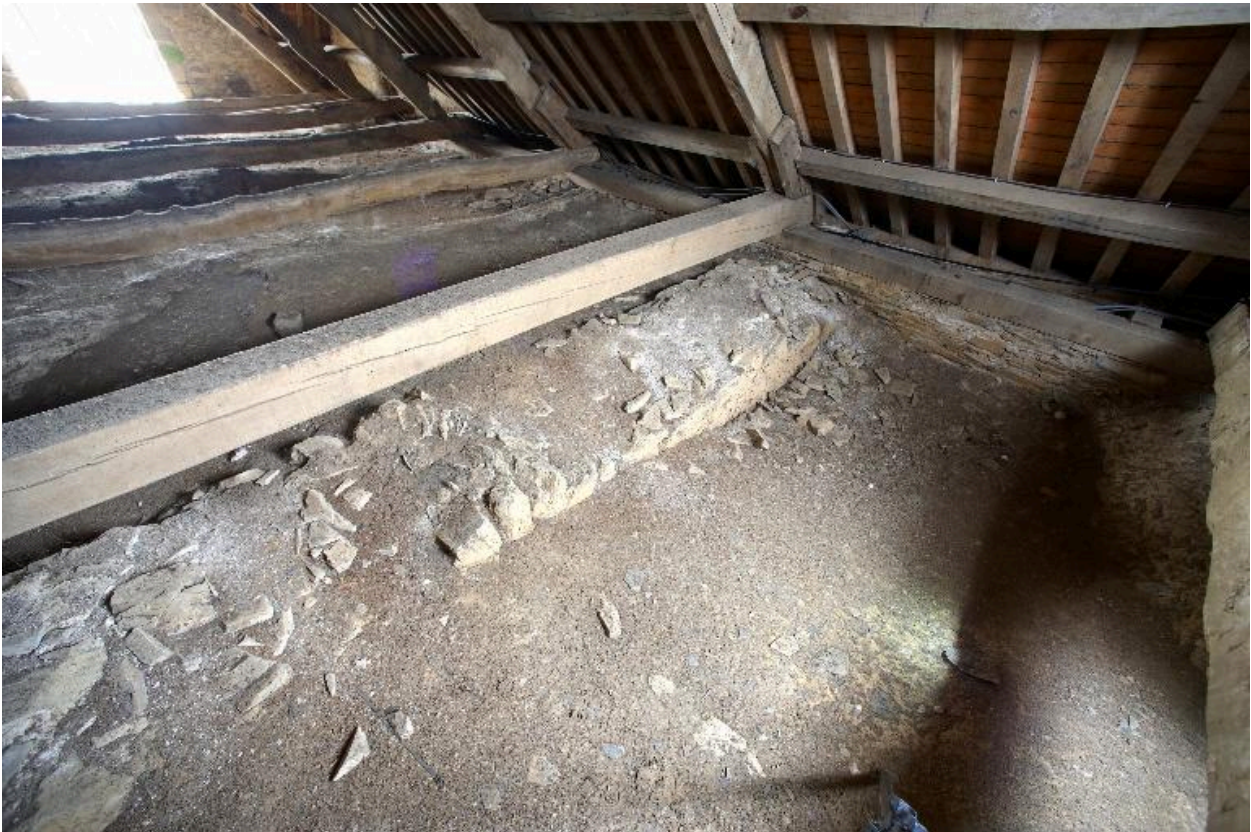
Comble du choeur, vue de l'extrados des voutes.
