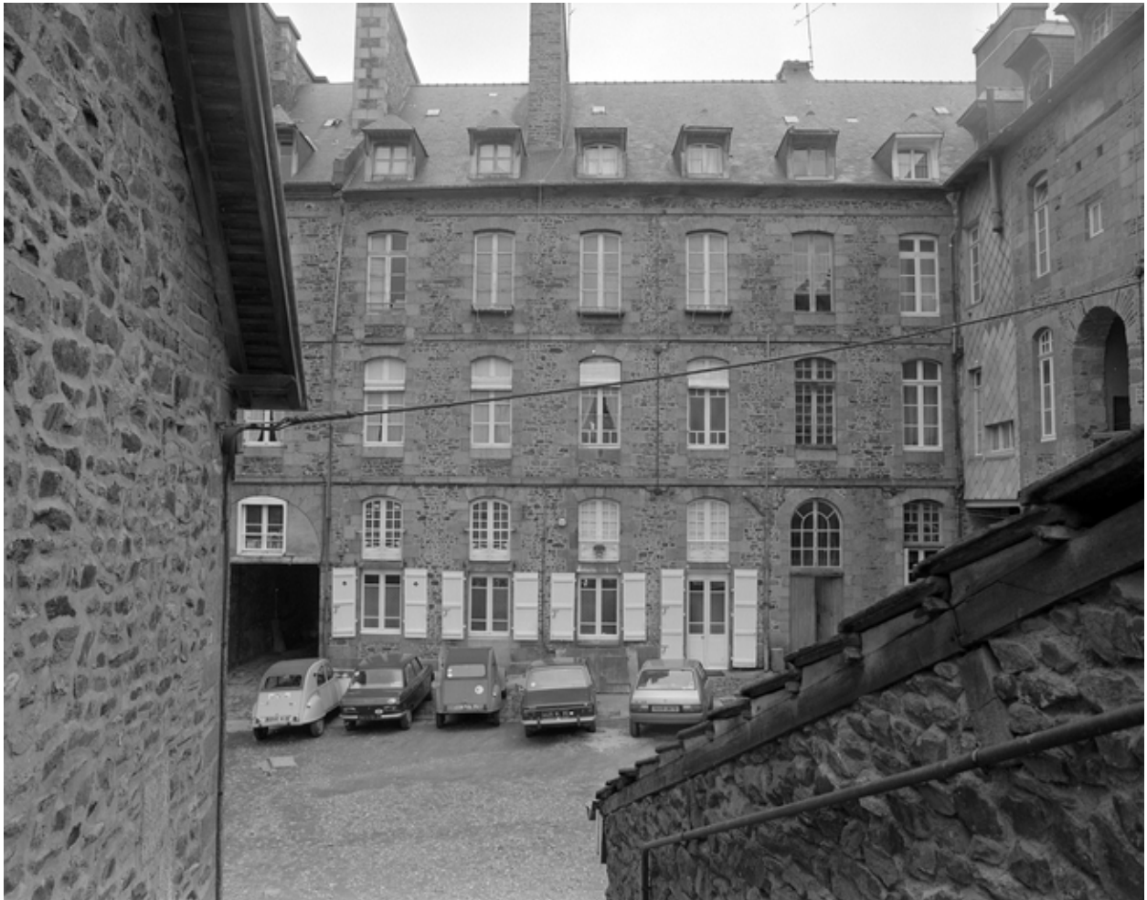
Elévation postérieur, corps principal, vue générale.
