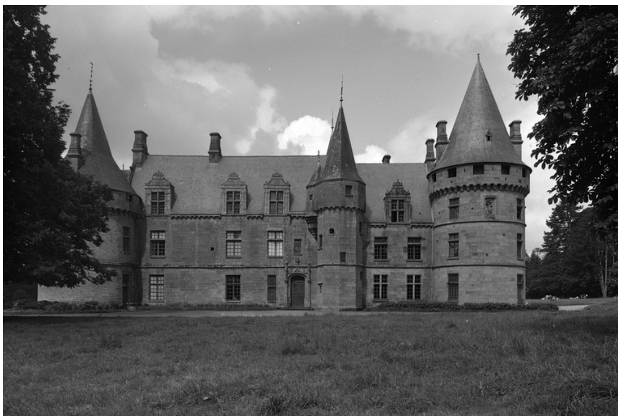
Elévation antérieure, vue générale.
