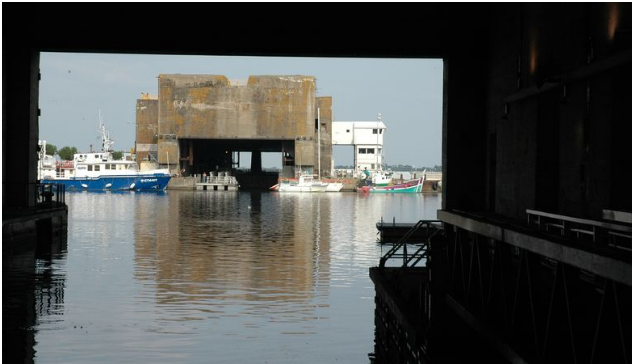
Vue de l'écluse bétonnée depuis une des alvéoles de la base de sous-marins
