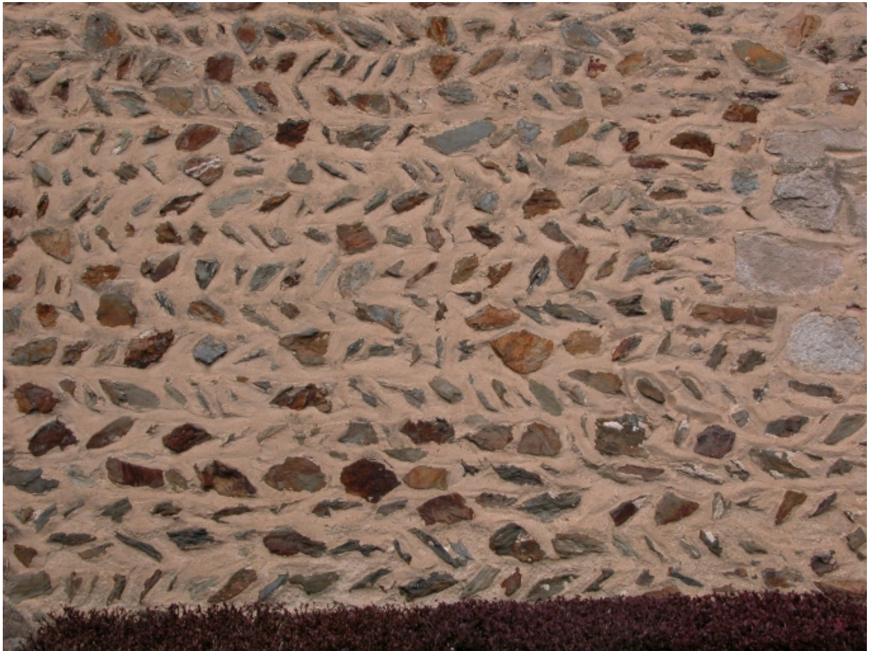
Pacé, église Saint Melaine, détail, appareil en feuilles de fougères (vestiges romans)
