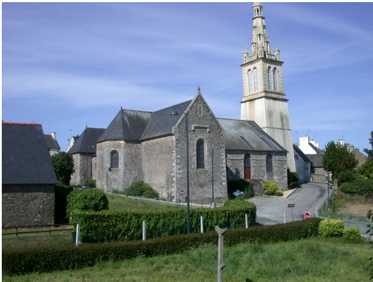
Vue générale nord-est
