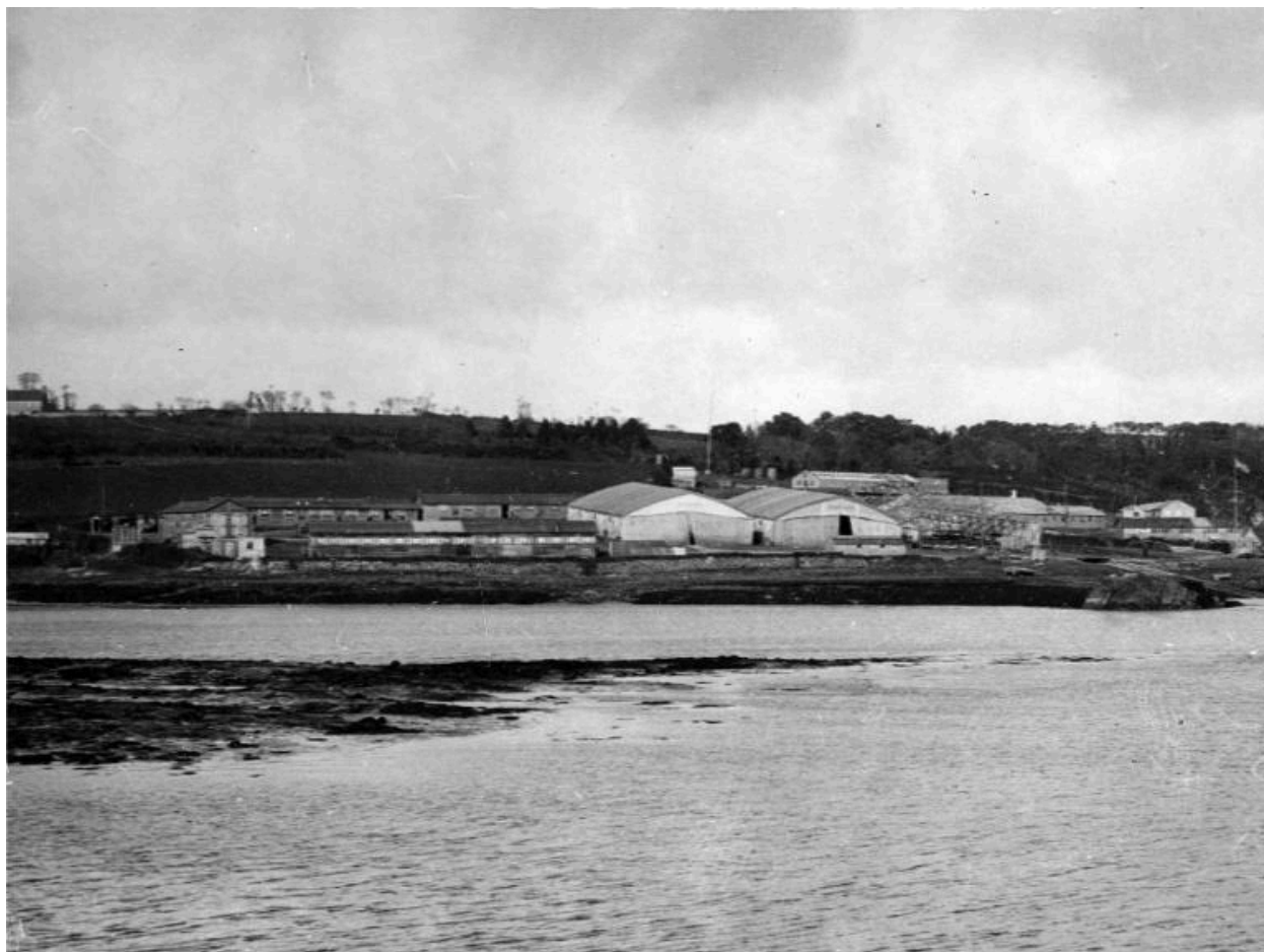
Vue de la Naval Air Station de Tréguier, 1918 (collection : Naval History and Heritage Command, UA 80.02.21). C'est également un poste de combat du CAM Penzé
