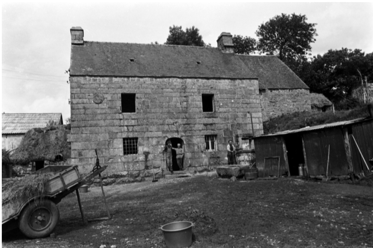
Face sud : vue générale
