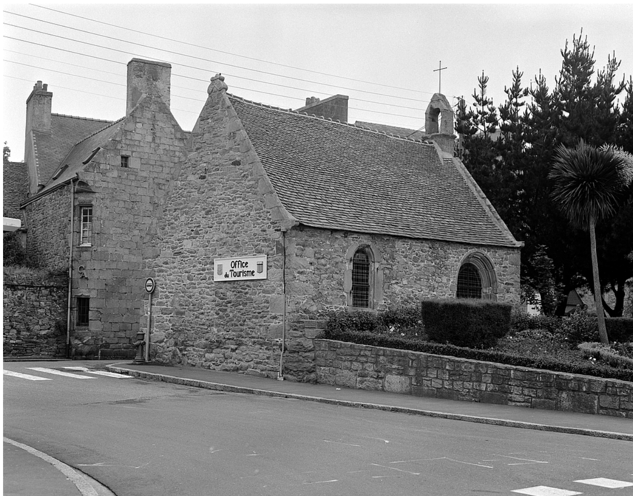
Elévation sud-ouest, vue générale
