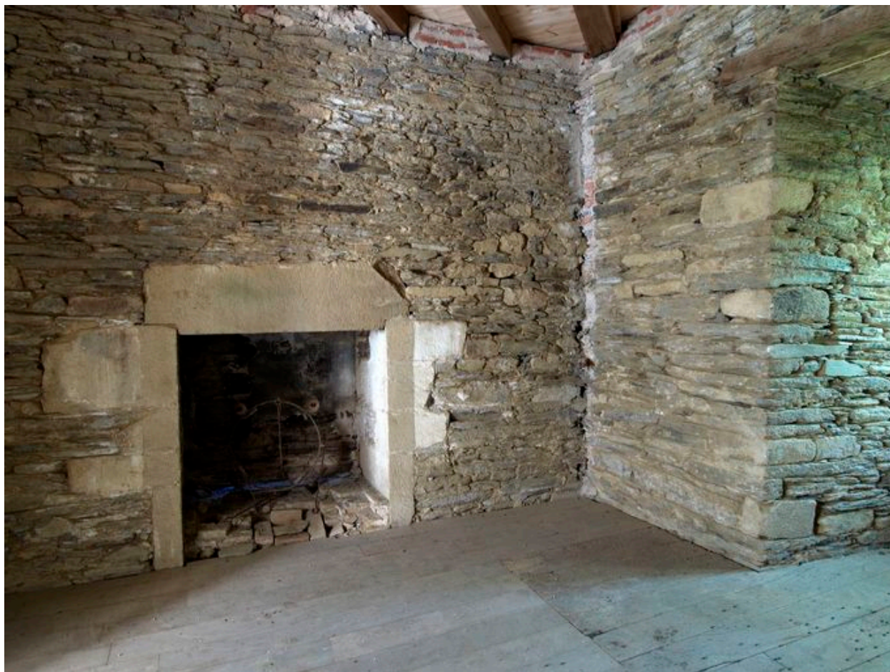
Château, tour isolée nord-ouest, étage : la cheminée (état en 2010)
