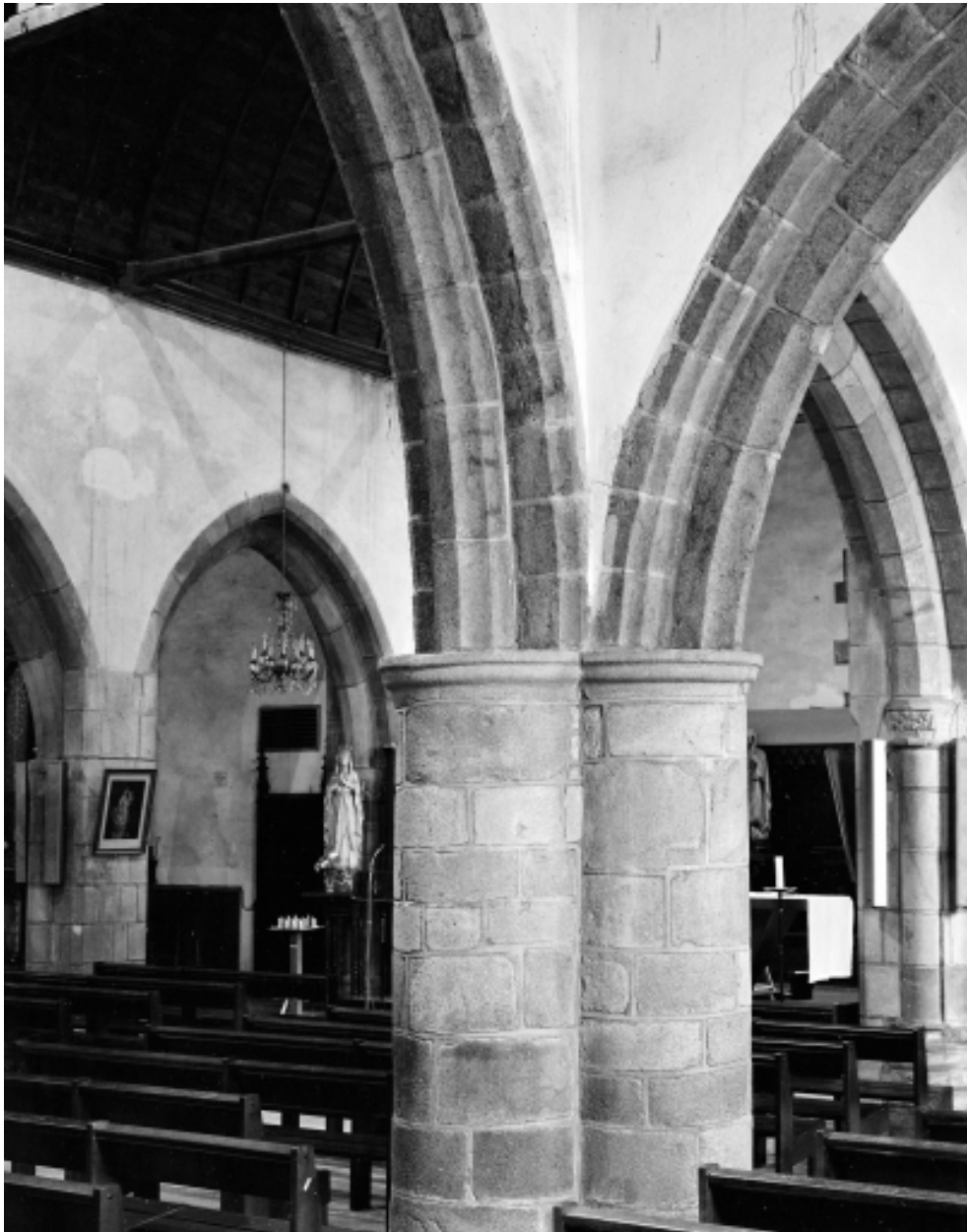
Nef, troisième pile Sud, vue générale
