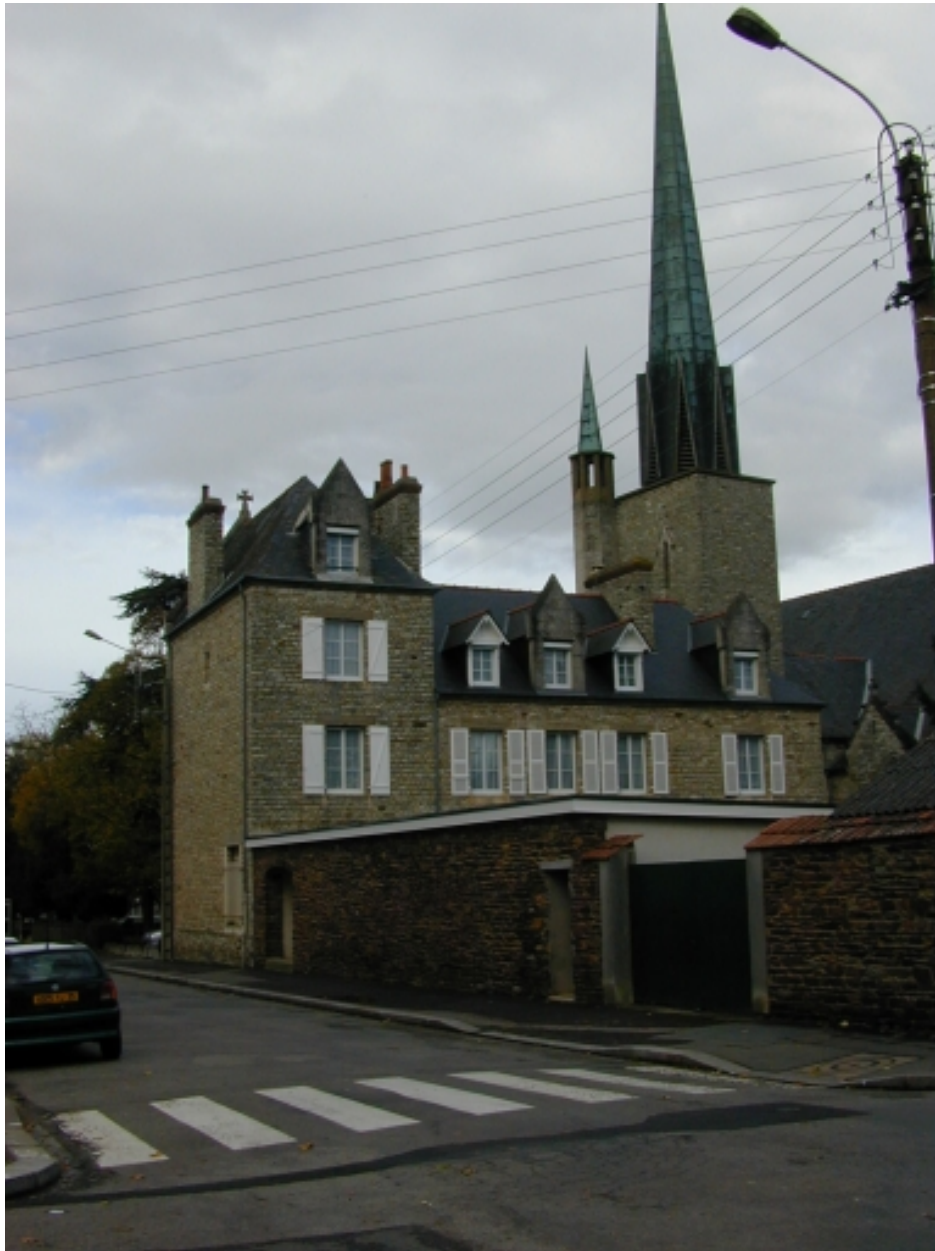
Vue du presbytère
