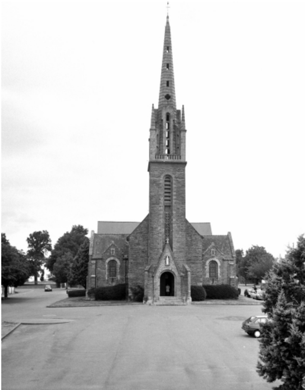
Elévation sud : vue générale
