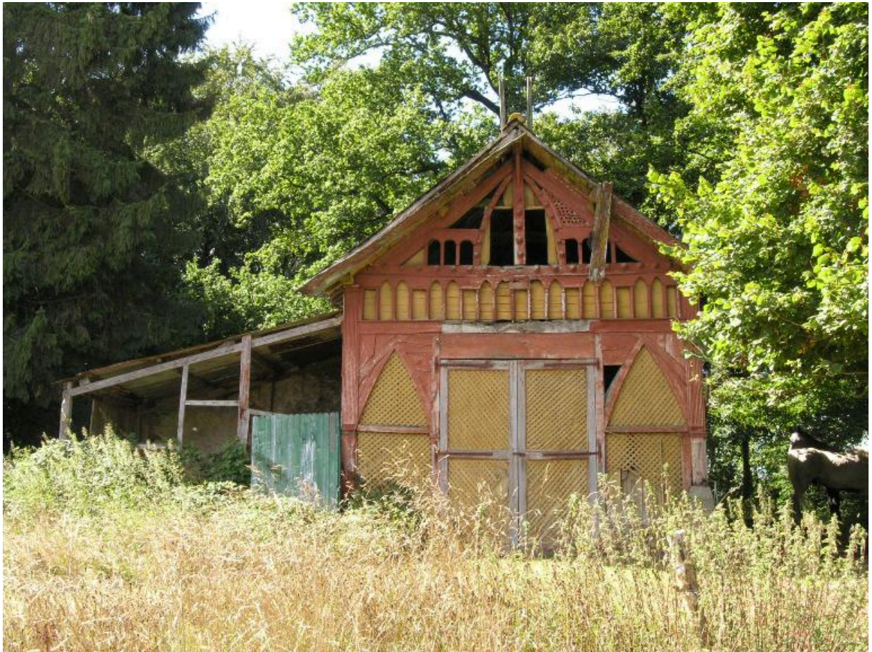
Détail d'une dépendance en bois
