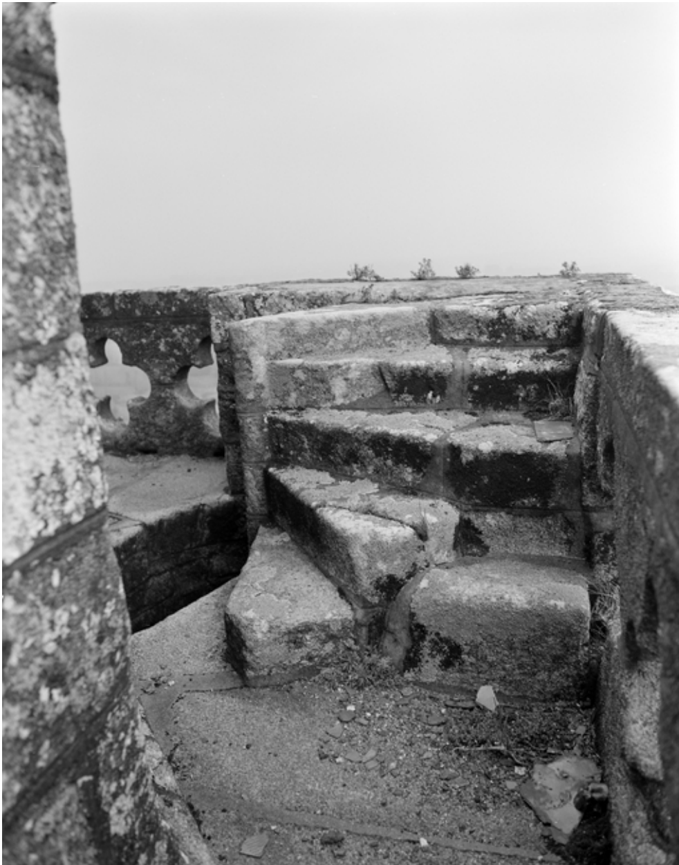
Tour-clocher, escalier de la terrasse
