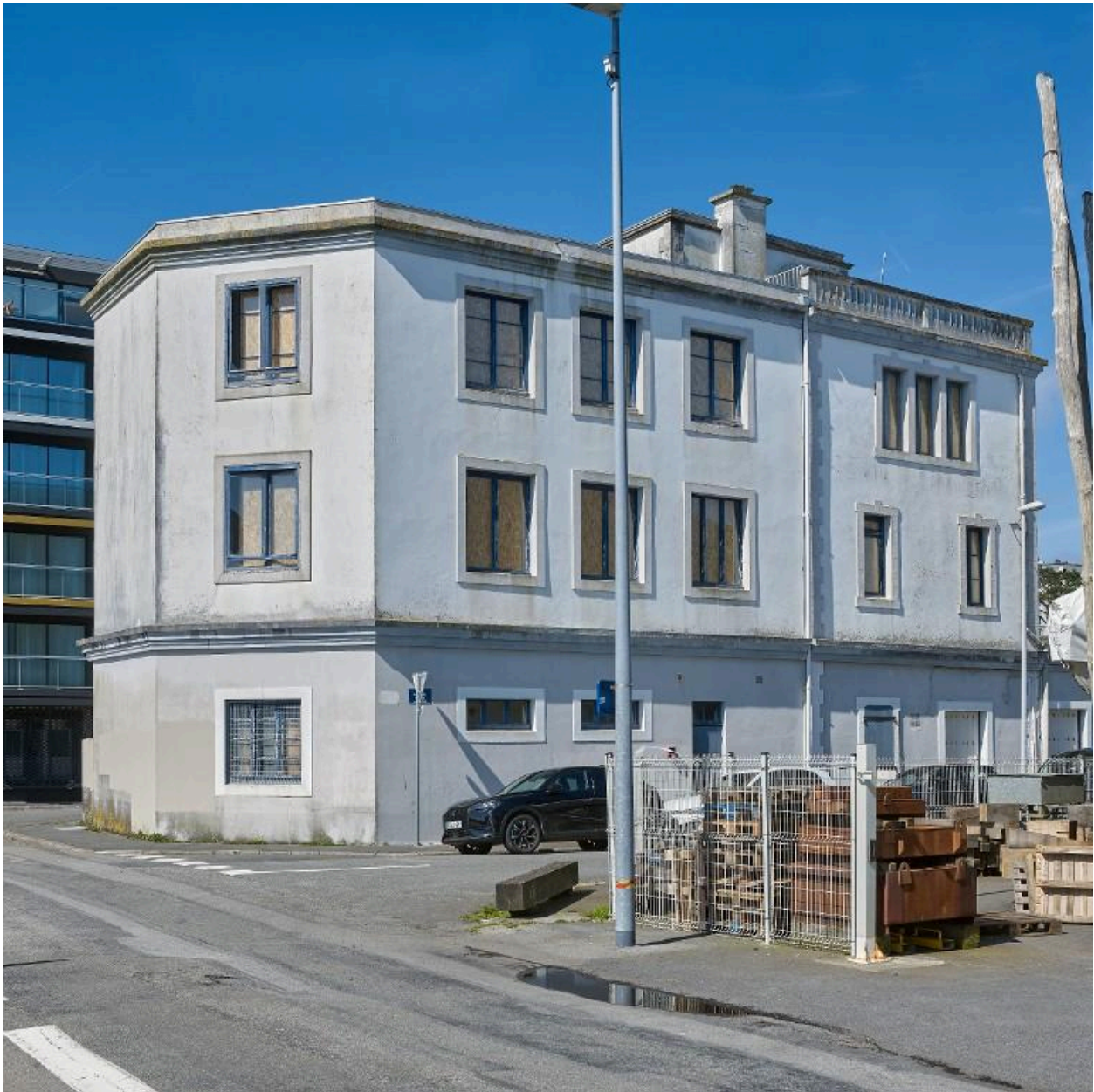
Ancien bureau du port, élévation sud
