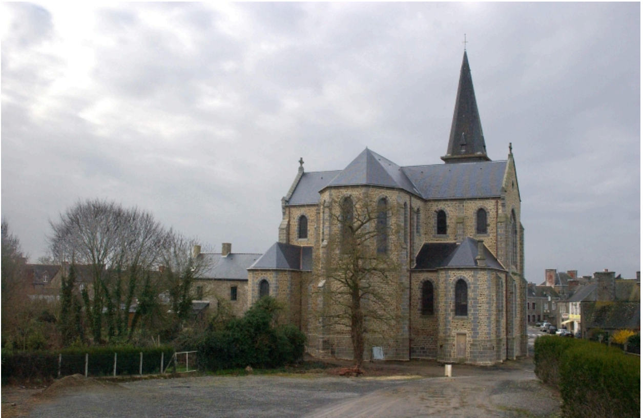
Vue générale nord
