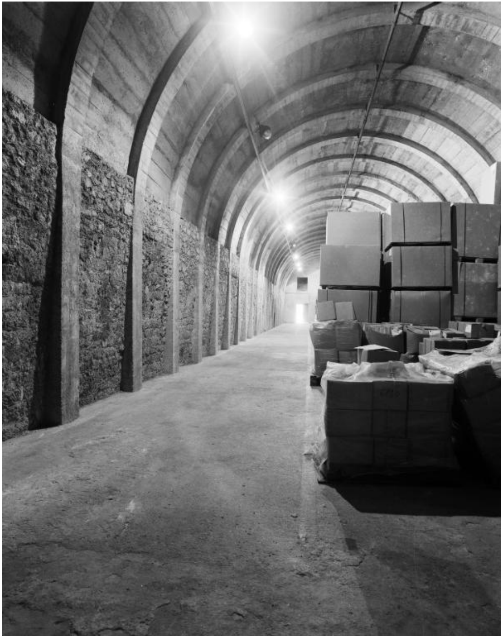
Magasin à poudre n° 2, vue intérieure vers le sud (état en 1998)
