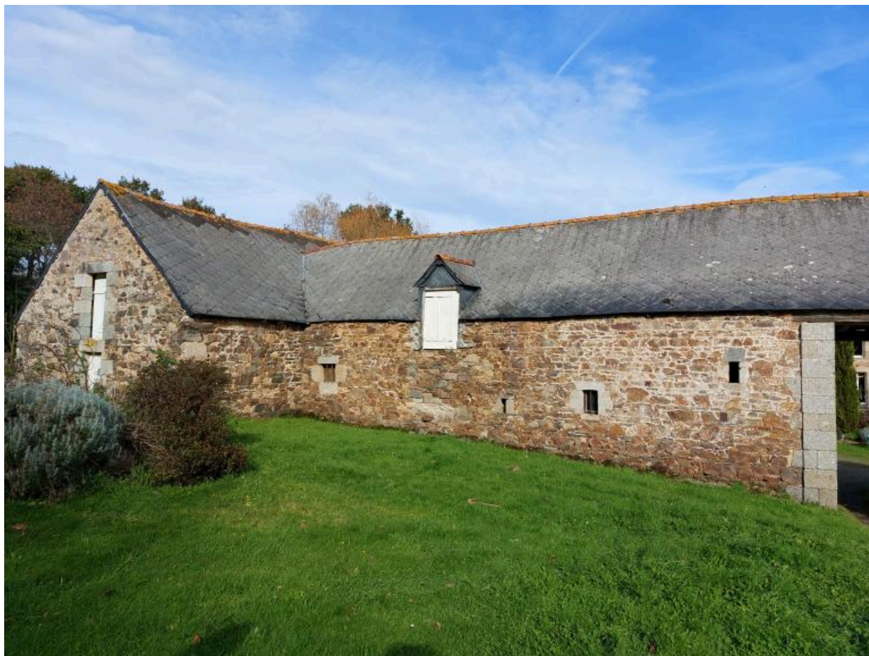
Partie des étables et écurie du porche du manoir de Panduonec
