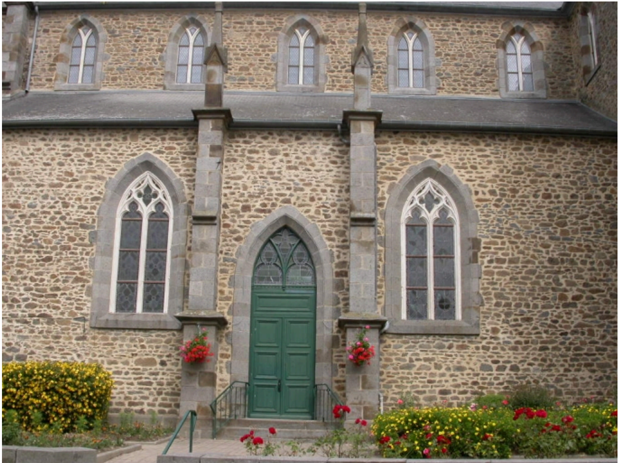
Façade sud, baies
