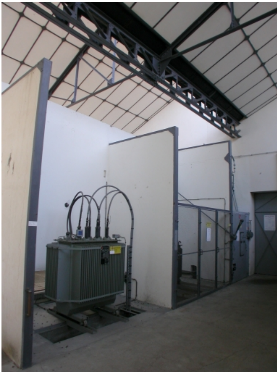
La "salle de relayage" couverte de sheds, vue intérieure.
