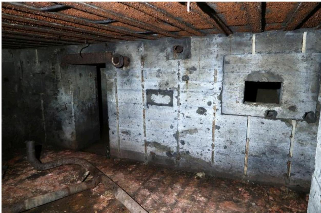
Vue de la salle de garde nord : accès de la petite salle, emplacement du ventilateur et créneau de tir. Les murs sont constellés d'éclats et noircis par la fumée. Le tuyau du système de ventilation gît au sol
