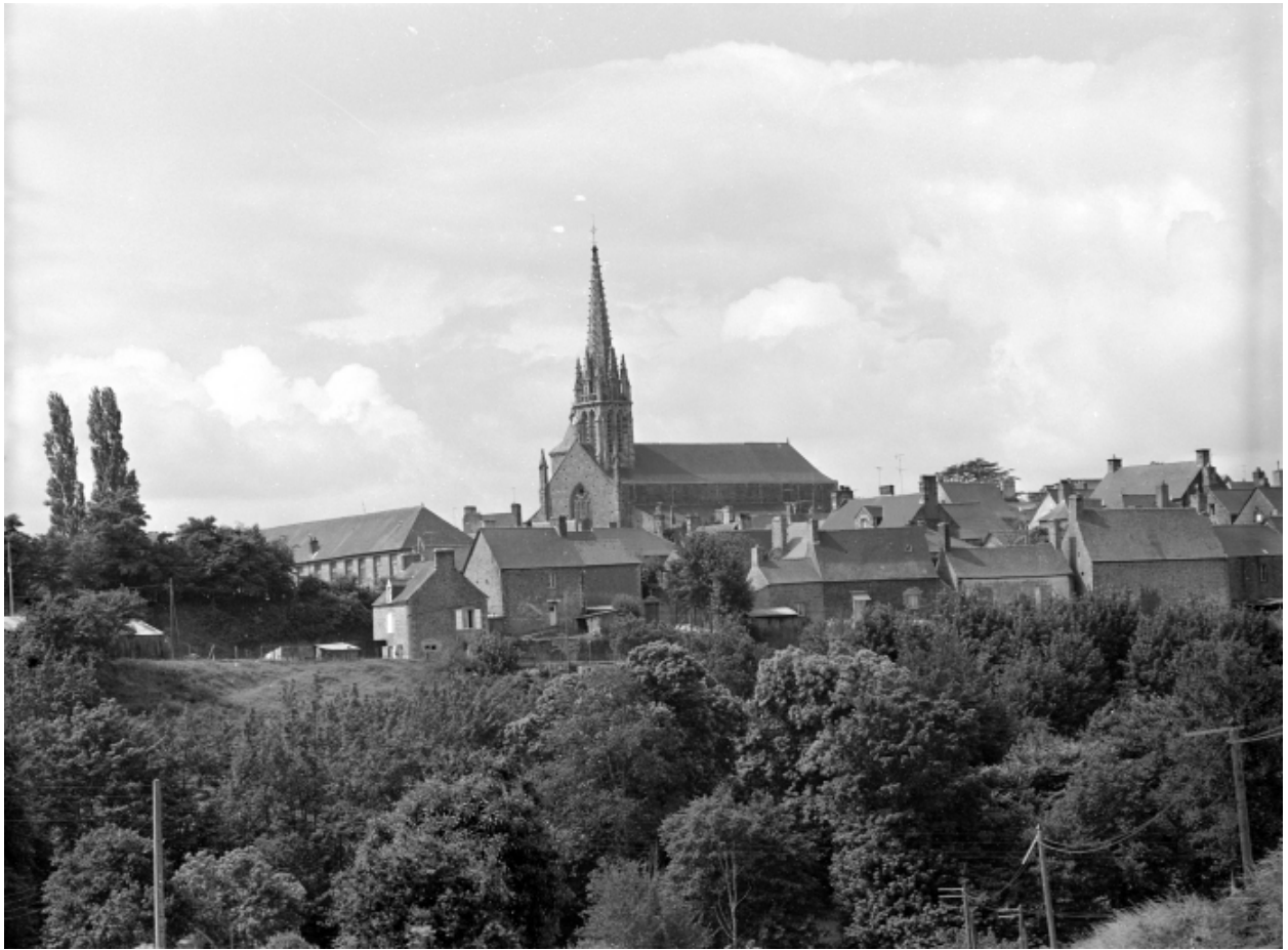
Elévation Nord-Est : vue de situation
