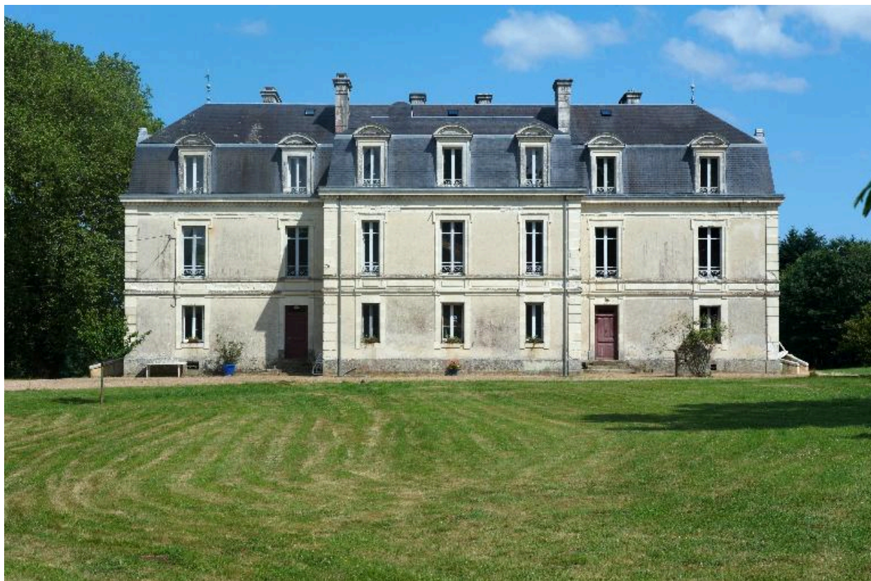
Façade ouest du château
