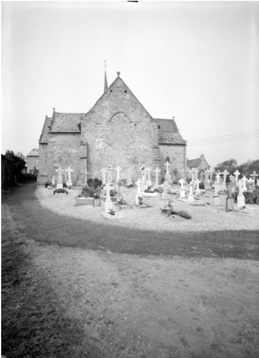
Elévation Est : vue générale
