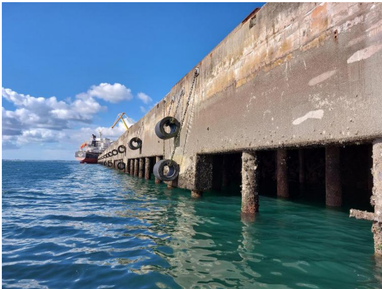
Quai sur pieux de la plate-forme multimodale
